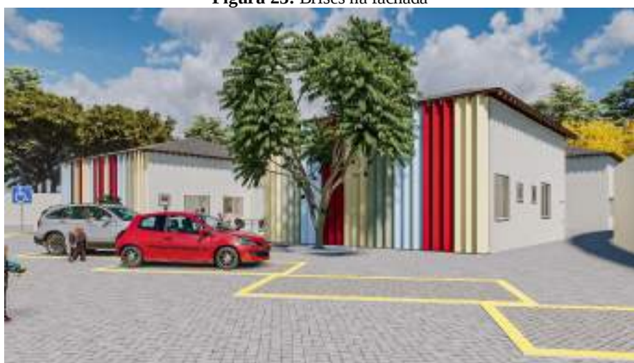
Figura 23: Brises na fachada
