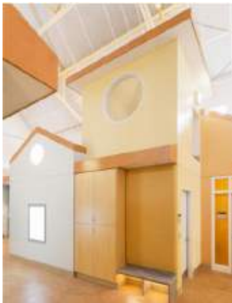
Figura 04: Edificação para aparelhos de ar condicionado no Centre for Autism and the Developing Brain
