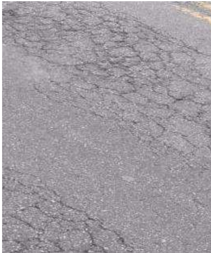
Figura 5 - Trinca por reflexão
