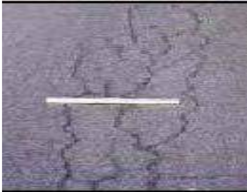
Figura 4 - Trinca de bordo
