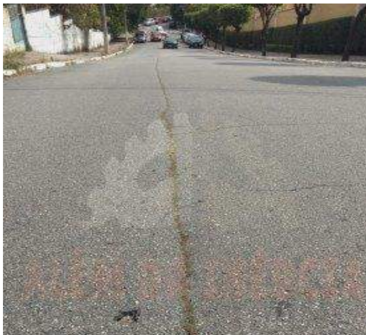
Figura 17 - Bombeamento
