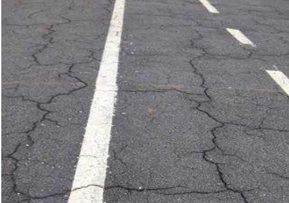
Figura 6 - Trinca em blocos
