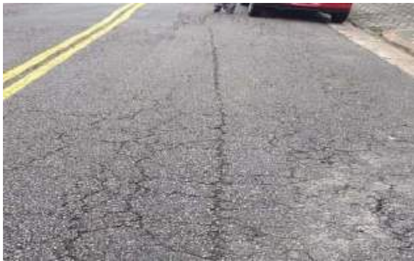
Figura 2 - Trincas longitudinal
