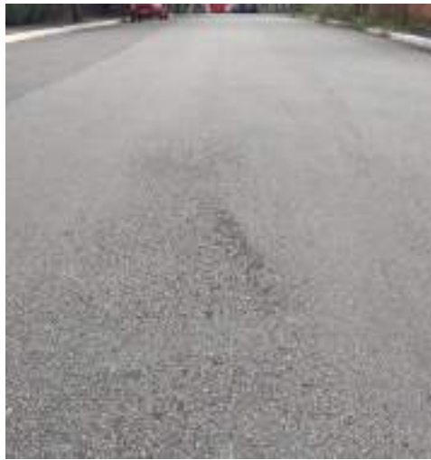
Figura 12 - Desgaste
