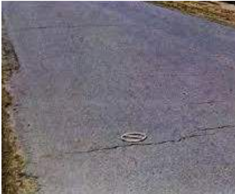
Figura 1- Trinca transversal
