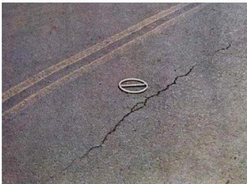
Figura 3 - Trincas longitudinal
