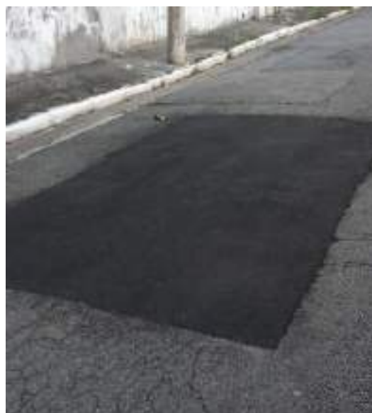
Figura 15 - Remendo
