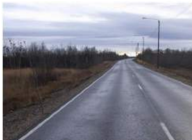
Figura 10 - Afundamento de trilho de roda
