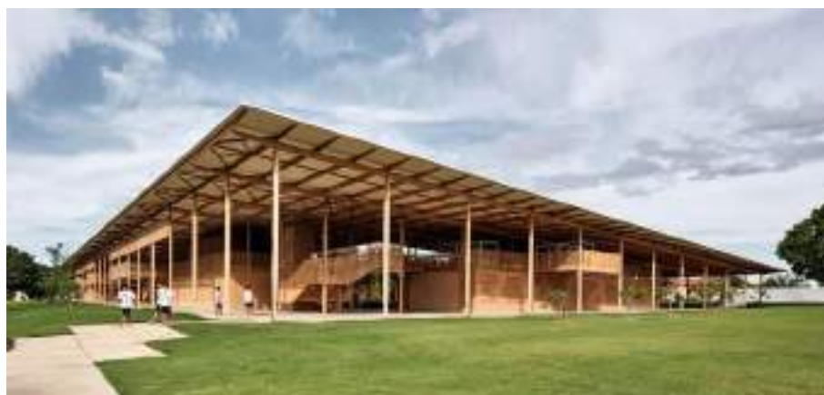
Figura 18: Moradia Infantil Fazenda-escola Canuanã - Fachada
