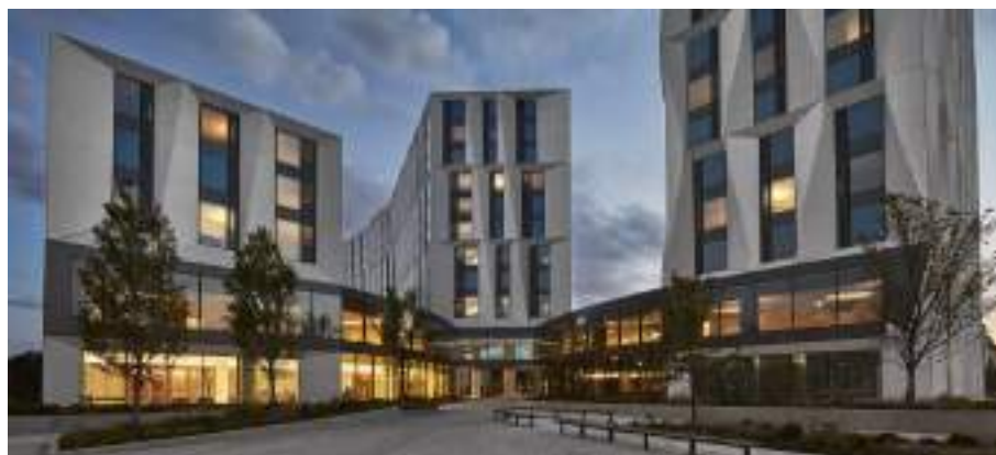
Figura 11: Moradia estudantil - Universidade de Chicago - Fachada
