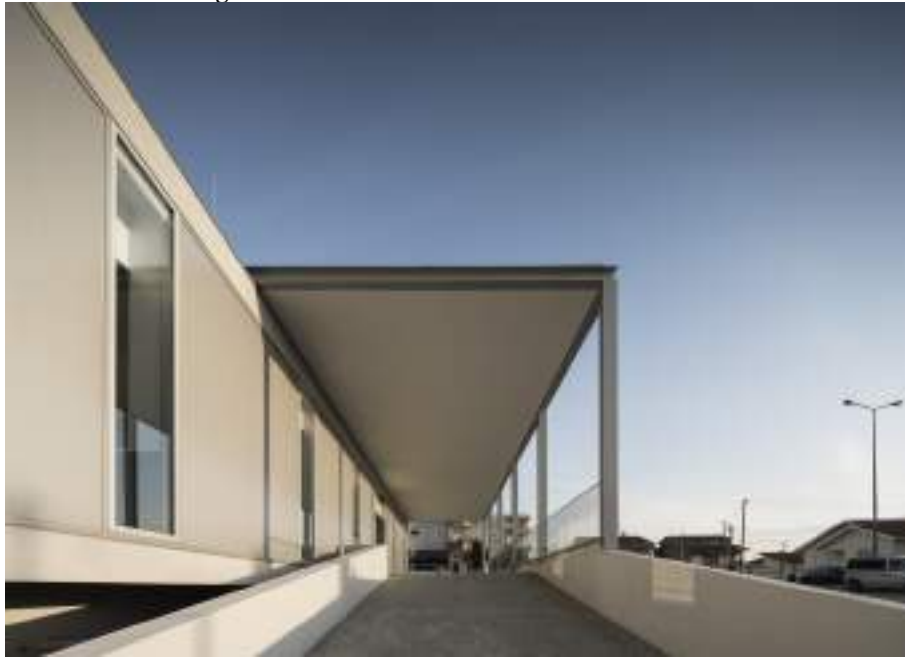
Figura 28: Clínica de hemodiálise de Nefrodouro
