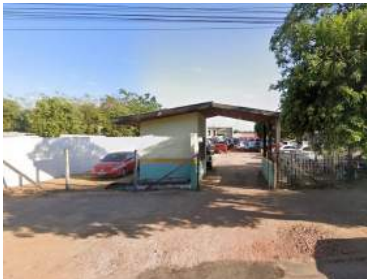
Figura 12: Entrada do estacionamento do Clube dos Idosos Dom Henrique
