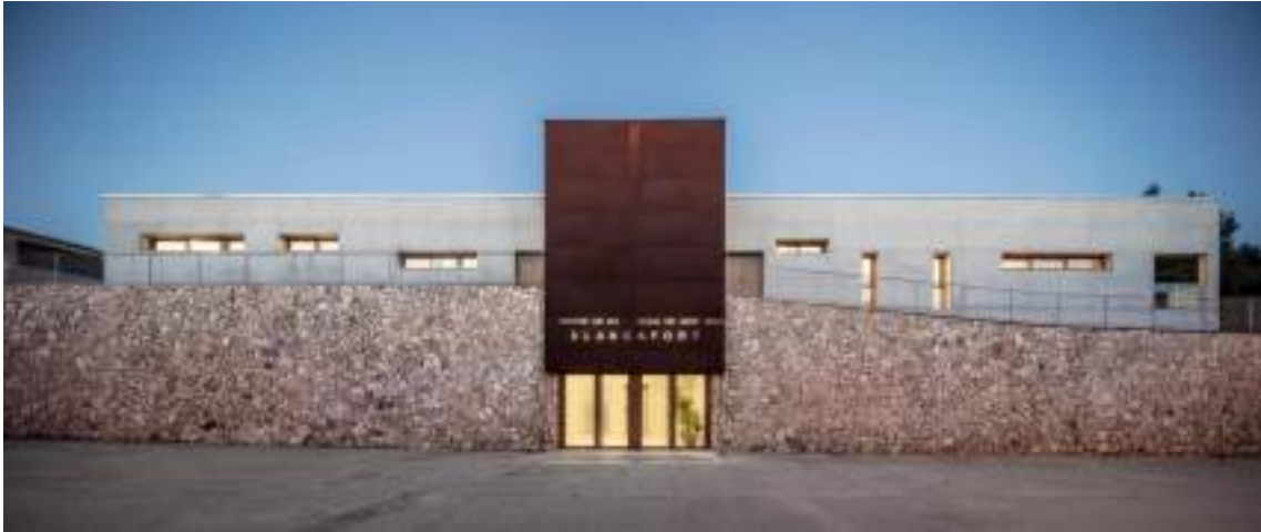
Figura 2: Fachada do Centro Dia e Lar para Idosos de Blancafort
