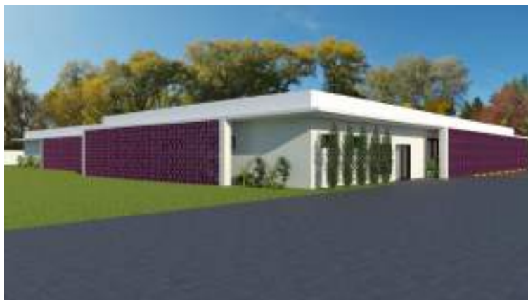
Figura 26: Fachadas com utilização de cobogós para sombreamento
