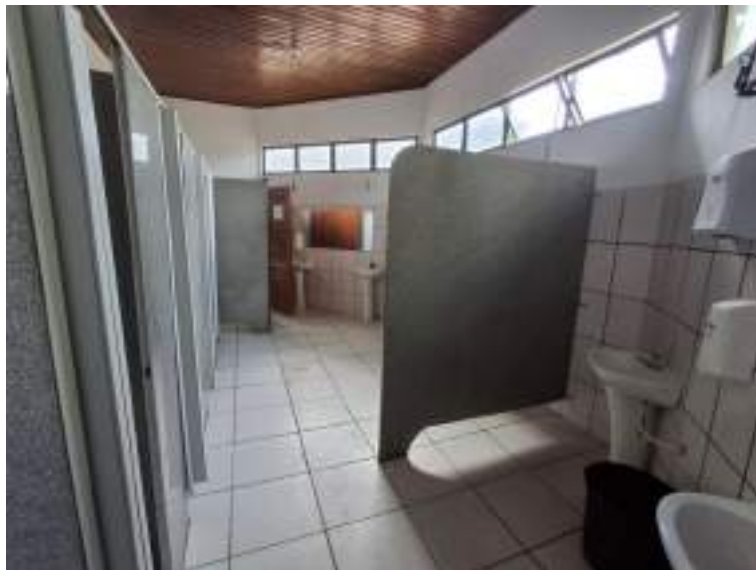
Figura 18: Banheiro masculino do Clube dos Idosos Dom Henrique
