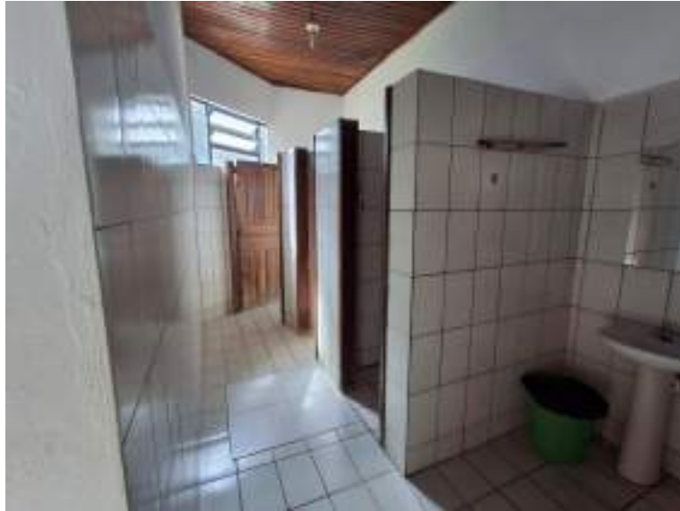
Figura 17: Banheiro feminino do Clube dos Idosos Dom Henrique
