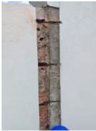
Figura 3: abertura de da área fissurada e fixação da tela.
