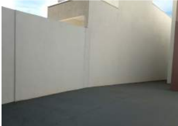
Figura 5: Pintura e acabamento da restauração.
