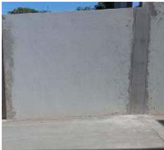
Figura 4: aplicação de argamassa e abertura de junta de dilatação.
