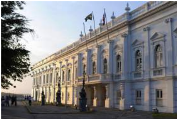
Figura 18 – Fachada do Palácio dos Leões.
