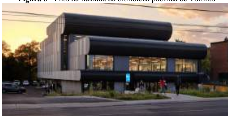
Figura 3 - Foto da fachada da biblioteca pública de Toronto
