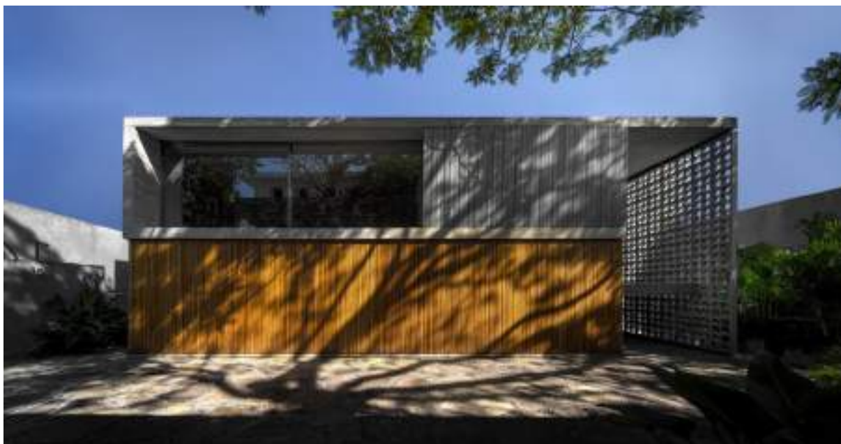
Figura 35: Fachada Casa B+B
