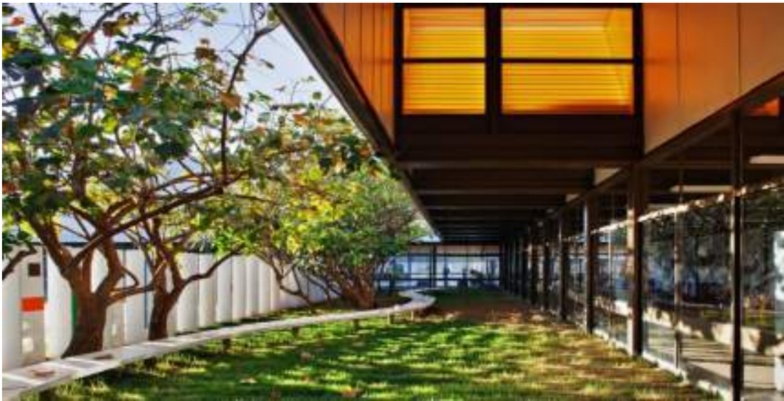
Figura 09: Fachada Centro de Reabilitação Sarah Kubitschek
