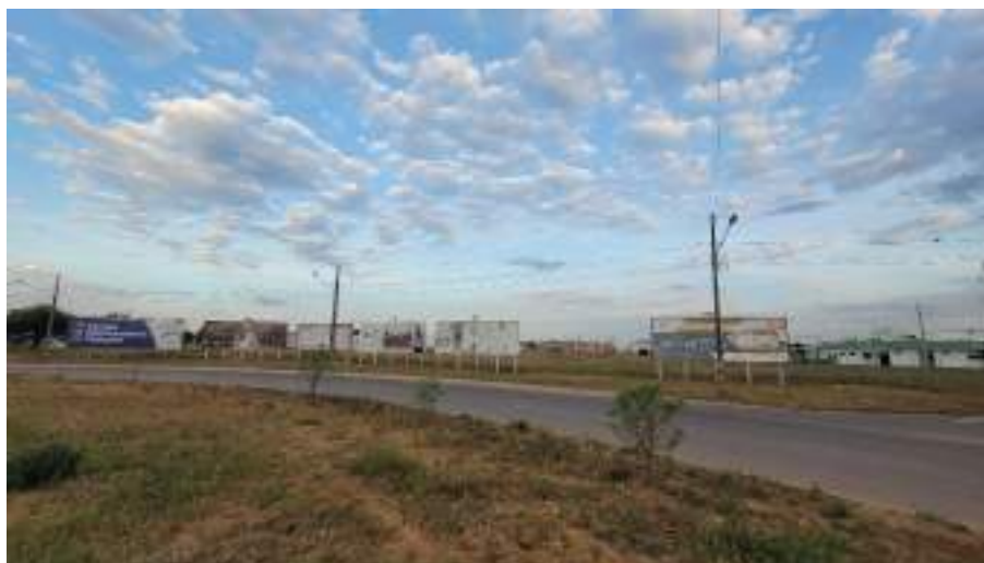
Figura 65: Vista da rotatória, Av. dos Ingás, sentido Av. dos Flamboyants
