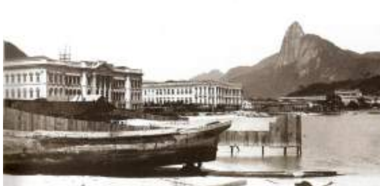
Figura 27: IBC - Primeira etapa de obras
