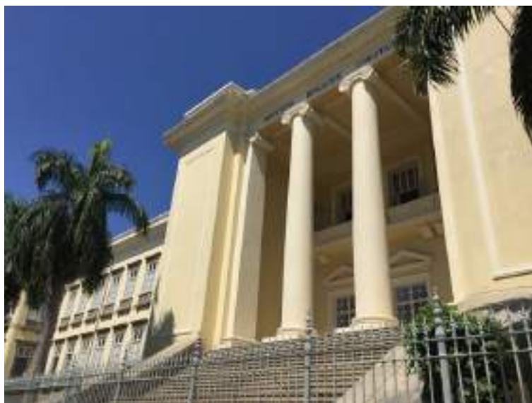
Figura 28: Fachada do IBC
