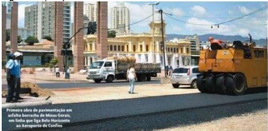
Figura 1 - Aplicação do asfalto borracha em Confins – MG.
