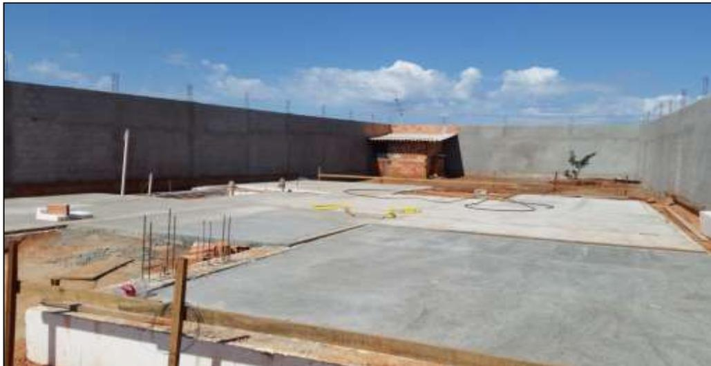
**Figura 2** - Fundação rasa (radier), pronta para receber os painéis
